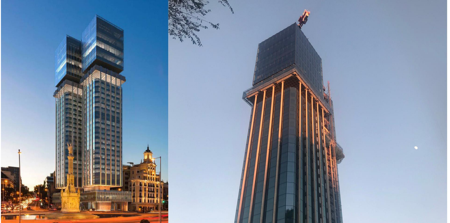
Rehabilitación Torres de Colón
